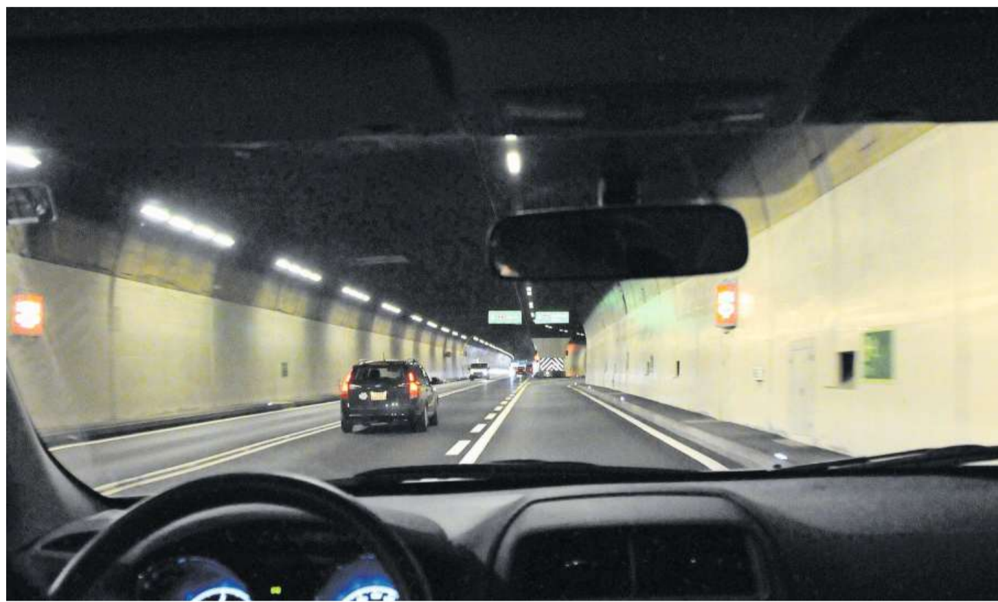
Im Lopper- und im Kirchenwaldtunnel werden nun vom Bundesamt für Strassen neue Überwachungskameras installiert.
