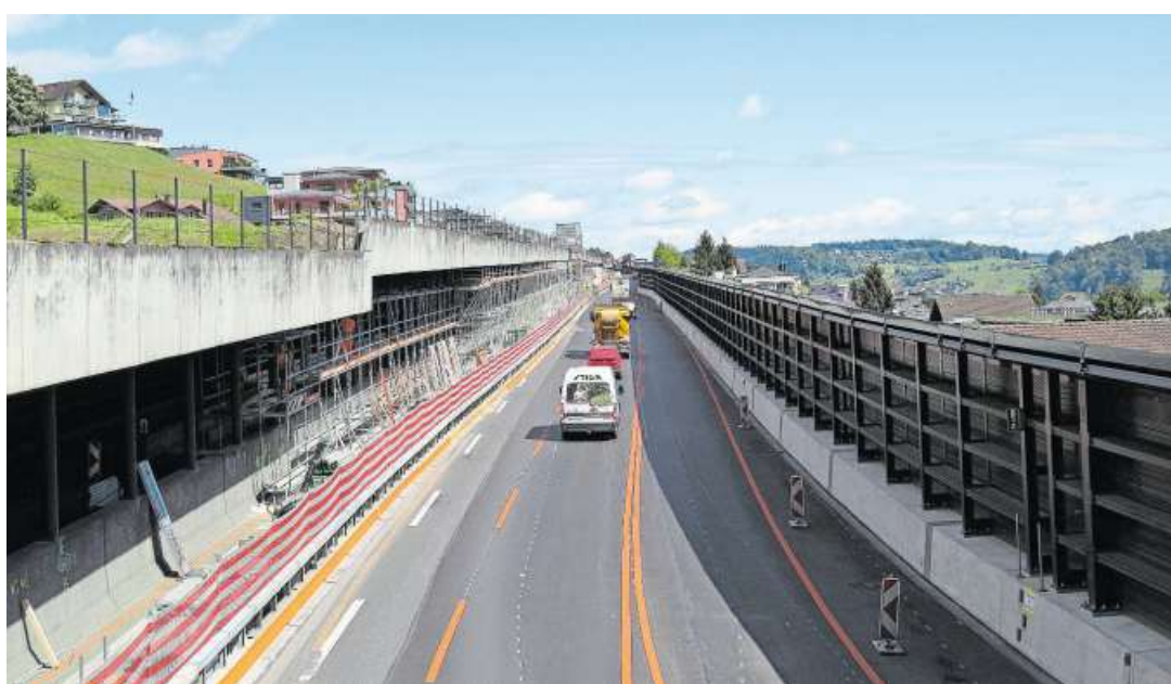
Die Baustelle bei Hergiswil wurde in die Mitte der A2 verlegt.
